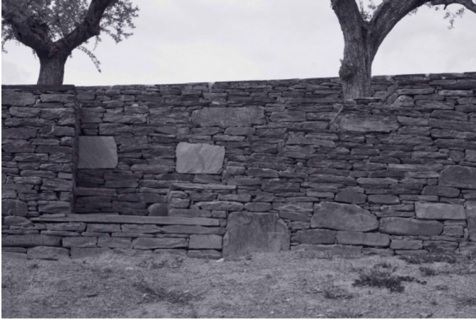
Figura 4 Escalera integrada en el espesor del muro.
