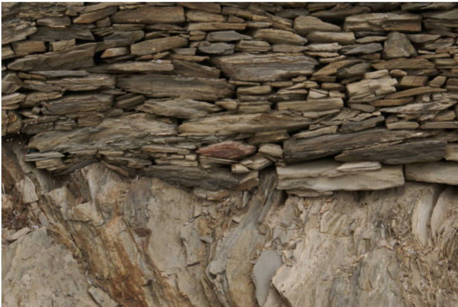
Figura 5 Detalle muro en Piedra seca.
