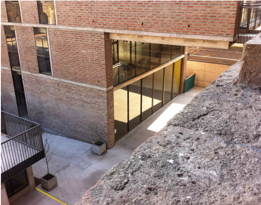
Edificio Académico de la Facultad de Artes UC, Campus Oriente, Santiago de Chile (JQ)
