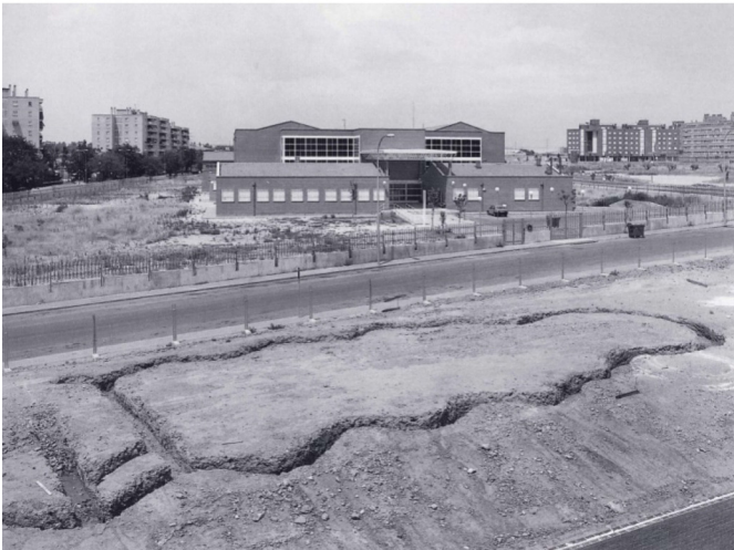
Figura 5 Excavación de las fundaciones de la Iglesia.
