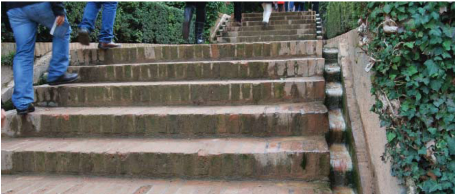
14 Alhambra. Una escalera conduce el agua superficial por simple gravedad.
