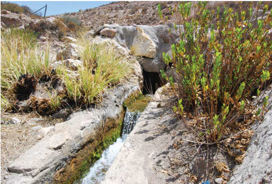
9 Socoroma, en Chile. La salida de un ducto subterráneo de captación.
