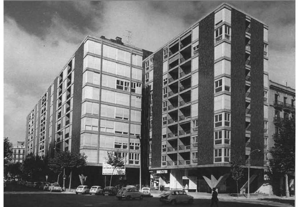
Esto se provoca aumentando el espesor del último forjado, repartiendo en este las cargas y minimizando el peso formal de la base; lo que provoca que se perciba todo el bloque de viviendas como un elemento que pareciera estar suspendido. Dicha base se encuentra retranqueada respecto a la línea de edificación, conformando una galería comercial que da un perfil más ancho a la acera peatonal.
